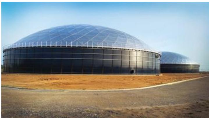
Des réservoirs d'eau SCAFCO ont été installés à la University of California, Teaching and Research Winery, Jess. S. Jackson Sustainable Winery Building. SCAFCO a fourni à ce vignoble quatre réservoirs d'eau de modèle 2105 avec une capacité d'entreposage totale d'environ 180 000 gallons (681 375 litres) d'eau. Le système de collecte de l'eau de pluie et de nettoyage de l'eau réutilise 90 % de l'eau.
