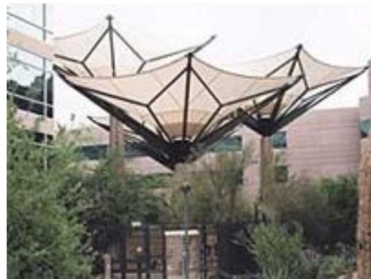
Structure de collecte de l'eau de pluie à planche inclinée      Soucoupes de pluie utilisées pour guider l'eau vers des citernes pluviales là où il n'y a aucune structure de toit ou dans des endroits éloignés
